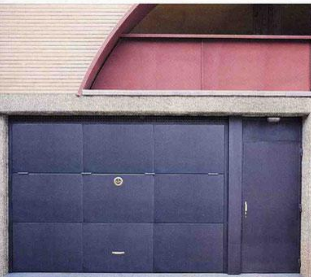
Porta basculant automàtica de dues fulles amb porta lateral de pas peatonal. Estructura de tub negre folrat en xapa de 3 mm, amb una mini reixeta superior de ventilació. L'acabat és modular.
